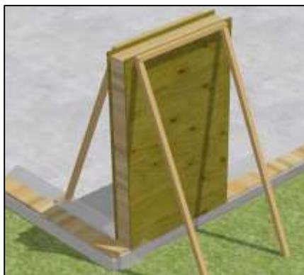
*Figura 8: Montaje del panel sobre la solera inferior. (Toloza 2018).*
