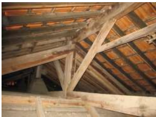
Figura 7: a) Estrutura principal em boas condições b) Elementos secundários degradados
