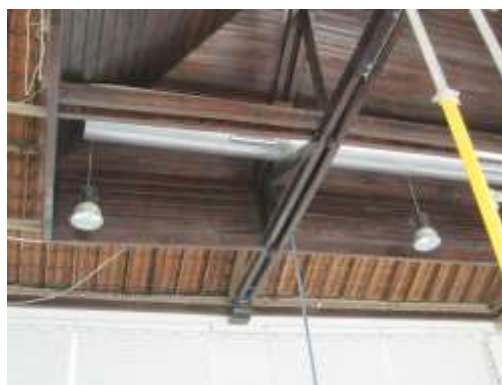
Figura 8: a) Linha fraturada b) Deformação excessiva no forro
