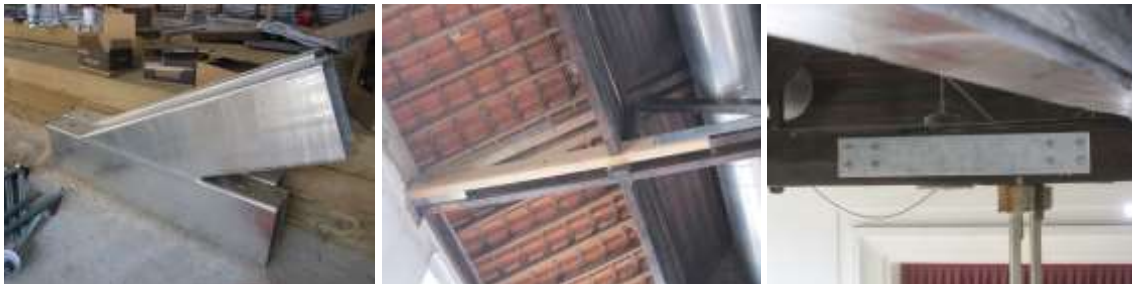
Figura 15: Execução a) Peças metálicas; b) linha partida; c) raio de Júpiter
