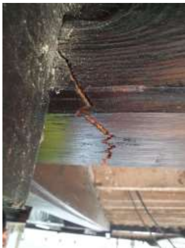
Figura 8: a) Linha fraturada b) Deformação excessiva no forro
