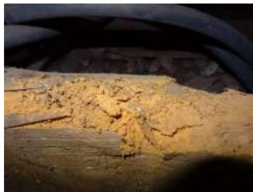
Figura 7: a) Estrutura principal em boas condições b) Elementos secundários degradados
