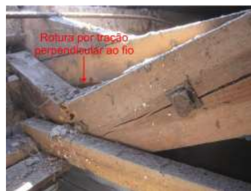
Figura 5: a) Rotura da peça central b) Rotura da ligação
