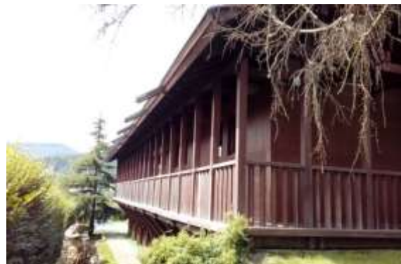
Figura 2: Detalle de la fachada oeste.
