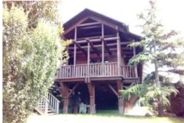
Figura 1: Vista frontal de la casa.
