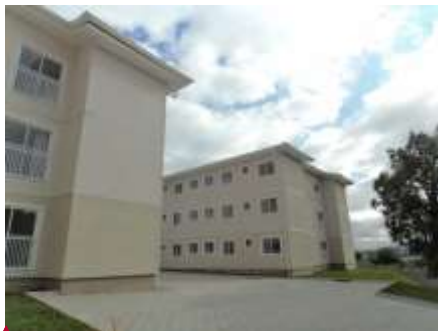
Figura 5 – Condomínio Vancouver, primeiros edifícios multifamiliares com 3 pavimentos, construídos pela TECVERDE. Fonte: TECVERDE
