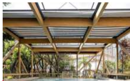
Figura 136 – cobertura de quadra em São Paulo – SP – MLC da CROSSLAM. Fonte: site CROSSLAM
