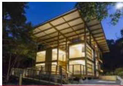
Figura 125 – Edifício da Fundação Florestal em Peruíbe-SP – MLC da REWOOD. Fonte: site REWOOD
