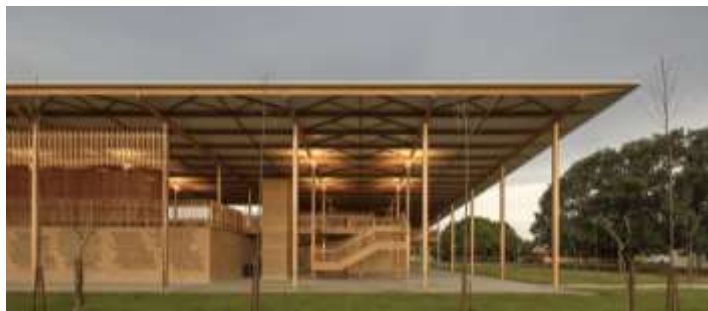
Figura 149 – Moradias Estudantis da Fundação Bradesco em Canuanã-TO, construída em Madeira Laminada Colada pela ITA Construtora. Fonte: archdaily
