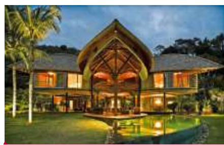
Figura 114 – Casa Folha, Construída em Angra dos Reis - RJ – MLC da ESMARA
