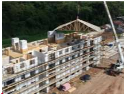
Figura 6 – Residencial Pinhais Park, primeiros edifícios multifamiliares com 4 pavimentos, construídos pela TECVERDE. Fonte: TECVERDE
