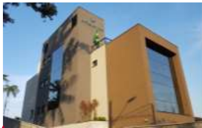
Figura 8 – Edifício Comercial de 3 pavimentos construído em Joinville SC, pela TECVERDE. fonte: TECVERDE
