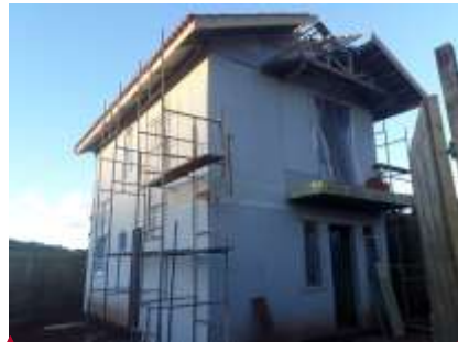
Figura 11-7 – sobrado residencial construído em Bituruna-PR pela Immergrun – Fonte Immergrun
