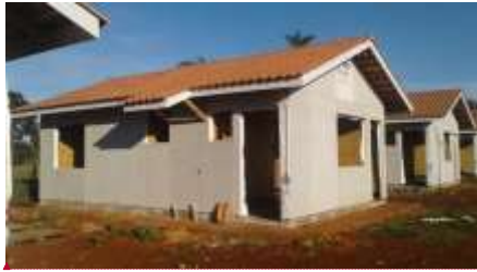
Figura 3 – Casas térreas em Durados – MS, construídos pela TECVERDE. Fonte: do autor
