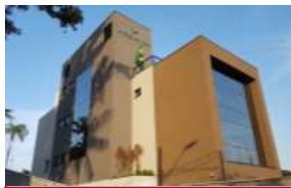
Figura 10 – Edifício Comercial de 3 pavimentos construído em Joinville-SC, pela TECVERDE. fonte: TECVERDE
