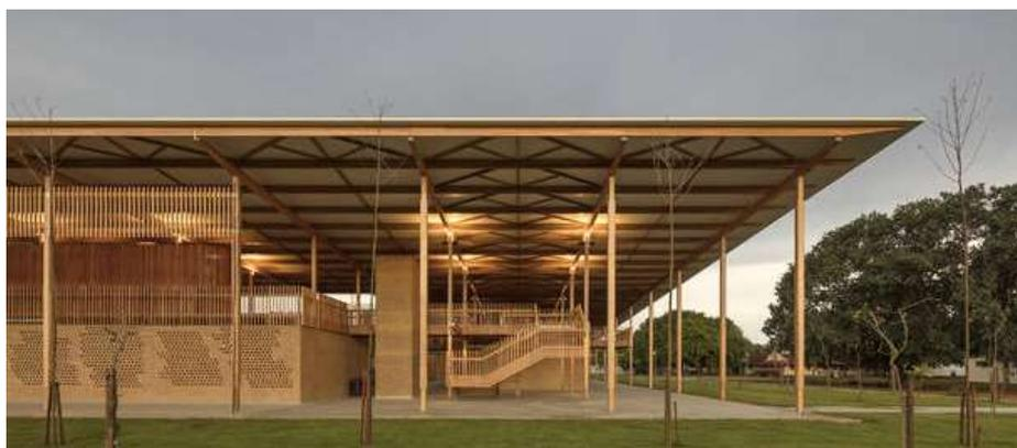
*Figura 14 – Moradias Estudantis da Fundação Bradesco em Canuanã-TO, construída em Madeira Laminada Colada pela ITA Construtora. Fonte: archdaily*
